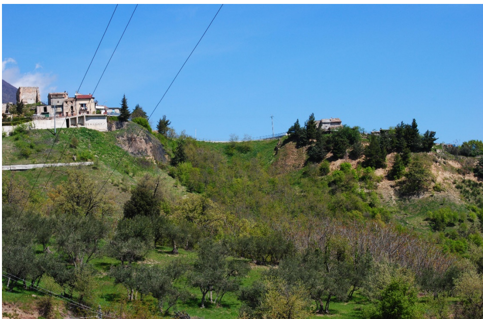
Visione attuale dell'area in cui presumibilmente avvenne la frana del 1545 che inghiottì la chiesa arcipretale di San Pietro (foto dell'autore).
